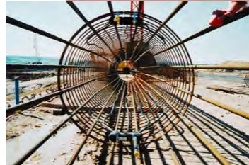
Cage d'armature pour un pieu énergétique moulé
